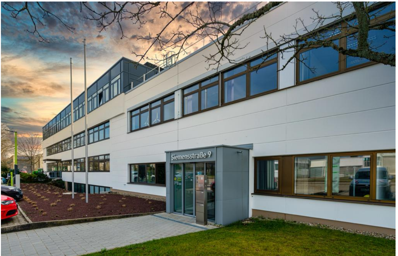
Abbildung 4 Gebäude Siemensstraße 9 in Ettlingen
