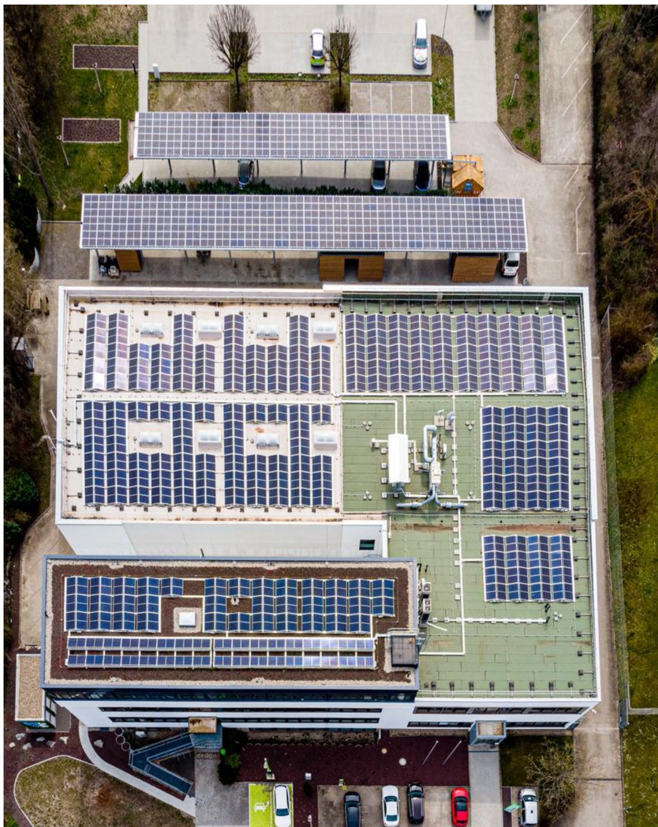
Abbildung 6 Luftbild Gebäude Siemensstr. 9 (Eigentum EnBW)
