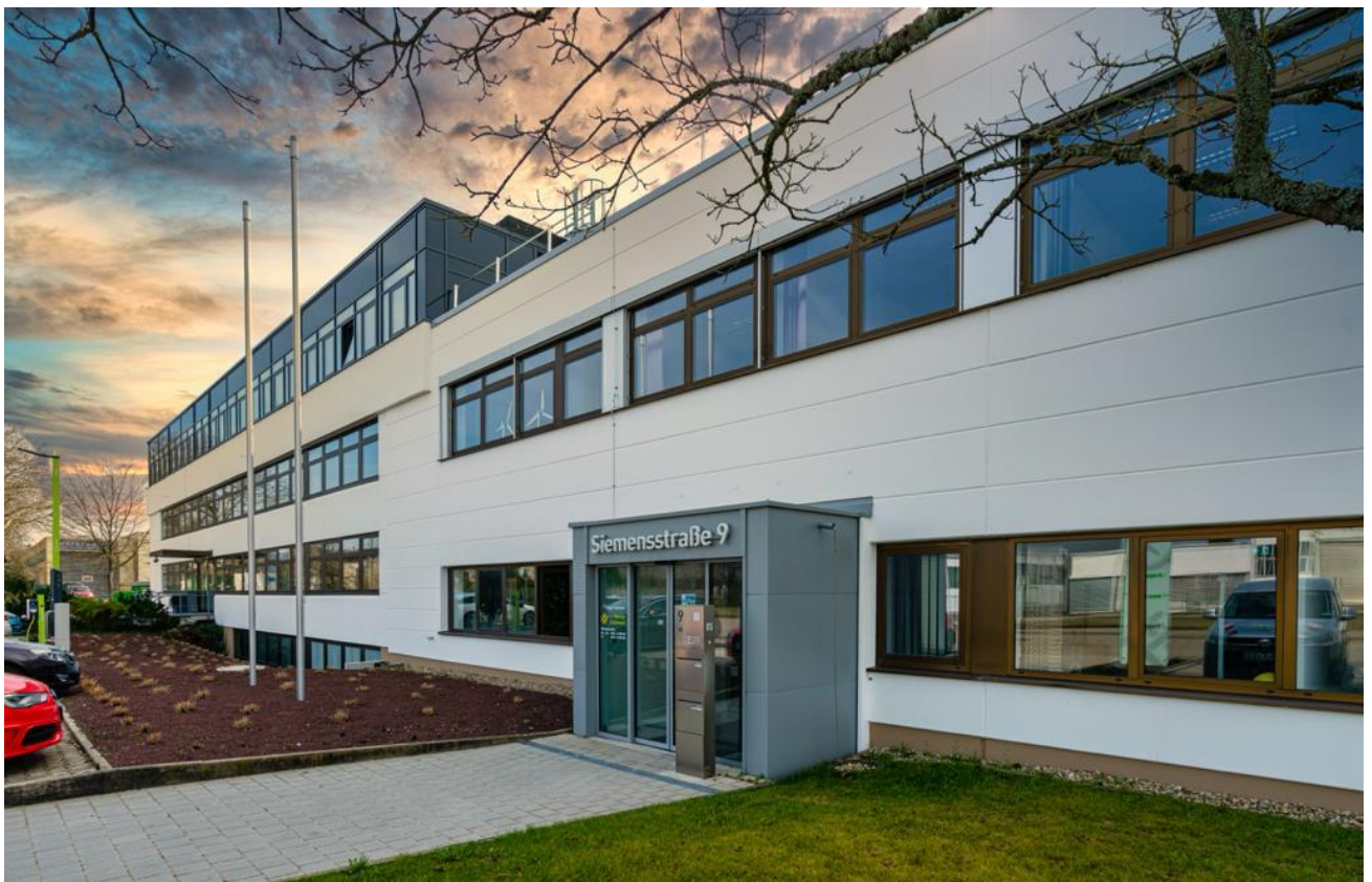
Abbildung 4 Gebäude Siemensstraße 9 in Ettlingen
